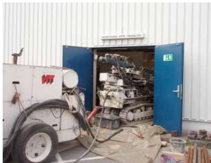
Bohrausrüstung für Mikropfähle
