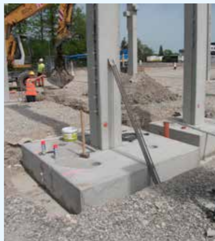
... schon bald kamen die ersten Stützen mit Fundamentfüßen ...
