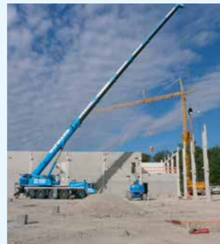
... und nach 6 Wochen standen die ersten Wände. +
