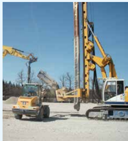
Für die Bodenverbesserung wurden hunderte Rüttelstopfsäulen eingebracht ...
