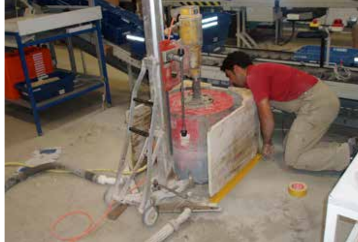
Mikropfahlbohrung im Innenraum
