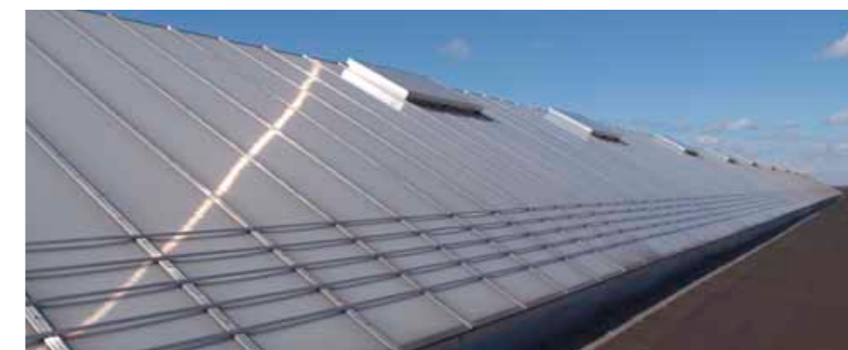
Anspruchsvolle Aufgabe: die Sanierung der Produktionshallen der Siemens AG in Duisburg.
