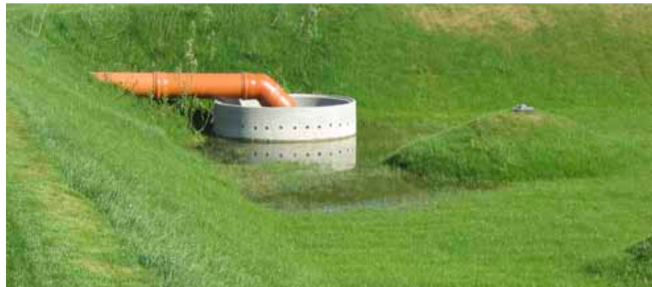
Das Niederschlagswasser wird über belebte Bodenschichten versickert.
