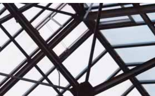
Besondere Herausforderung: Komplexe Deckenkonstruktion in 30 Metern Höhe.
