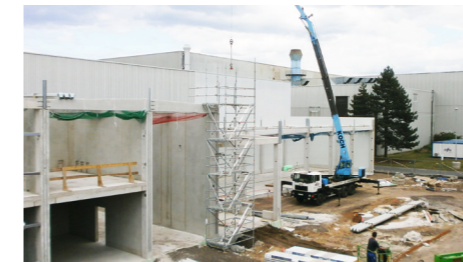
Baustelle in Rekordzeit
